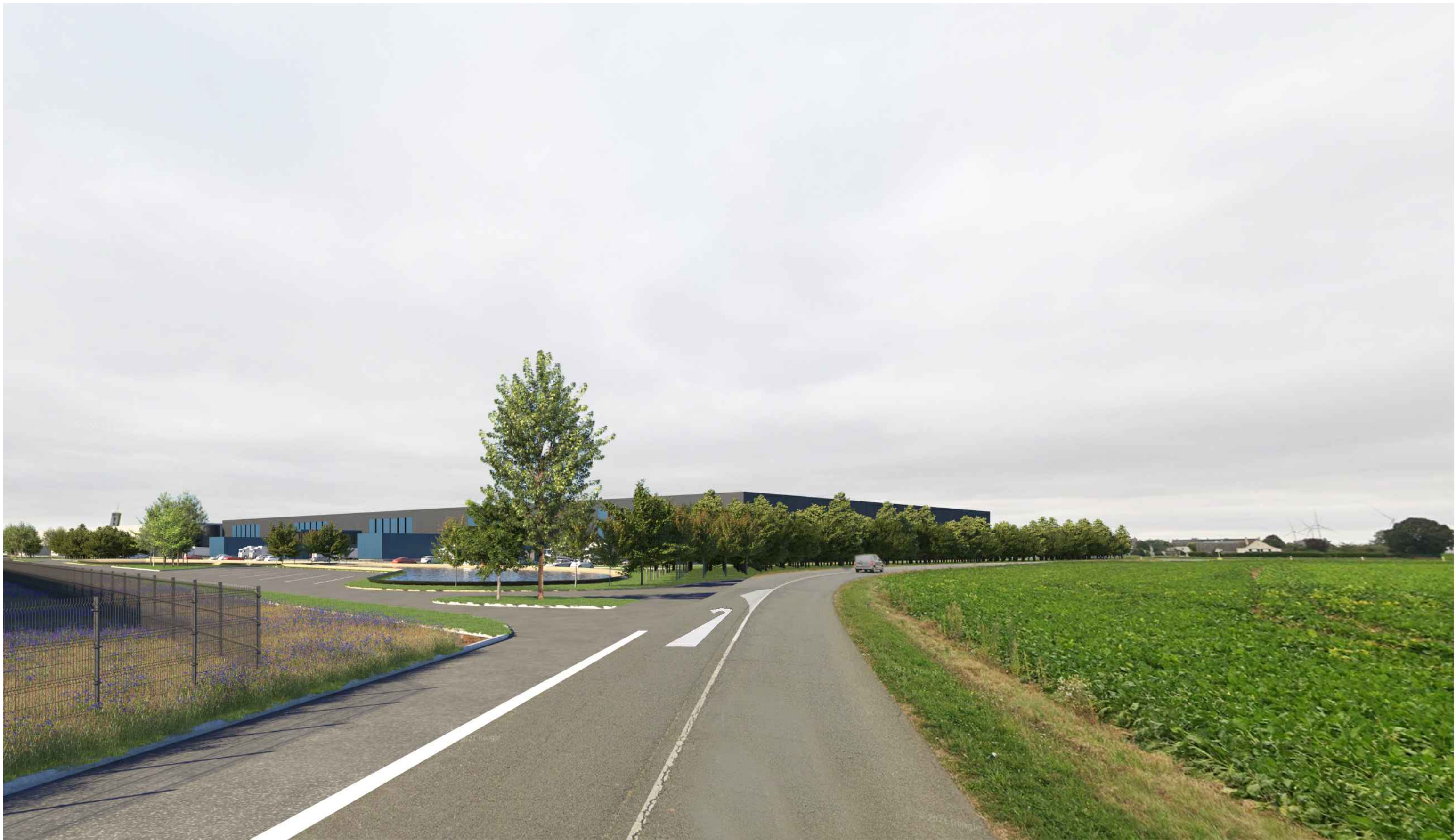
2 - INSERTION DANS L'ENVIRONNEMENT (VUE DEPUIS LA RD 3.13) PONT)
